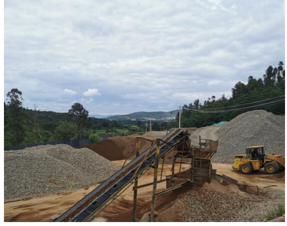
2#生产线产品堆场现状（现有）
