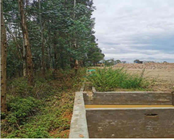
现状截水沟、沉淀池
