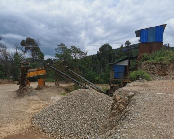
1#生产线破碎筛分现状（现有）
