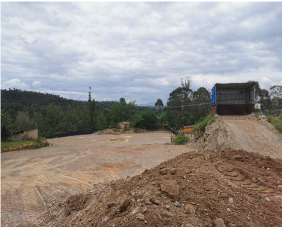
1#生产线产品堆场现状（现有）
