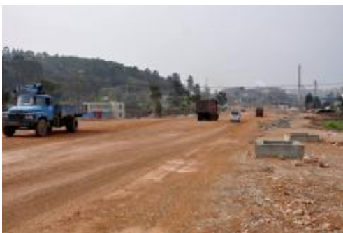
图 1-1 安海公路施工现场
