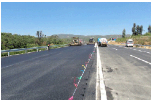
图 1-3 县草公路沥青路面工程
