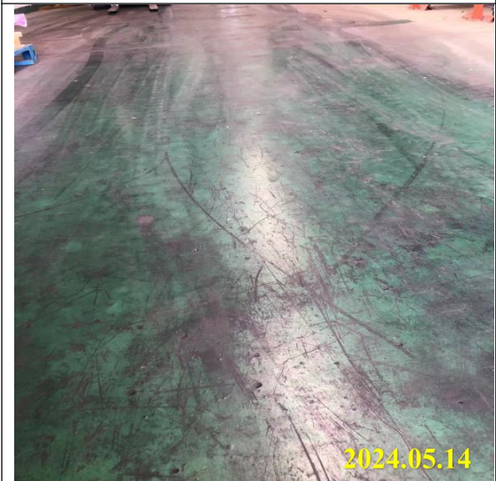
3#厂房内硬化的路面
