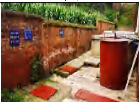
云南云叶化肥股份有限公司已建初期雨水收集池
