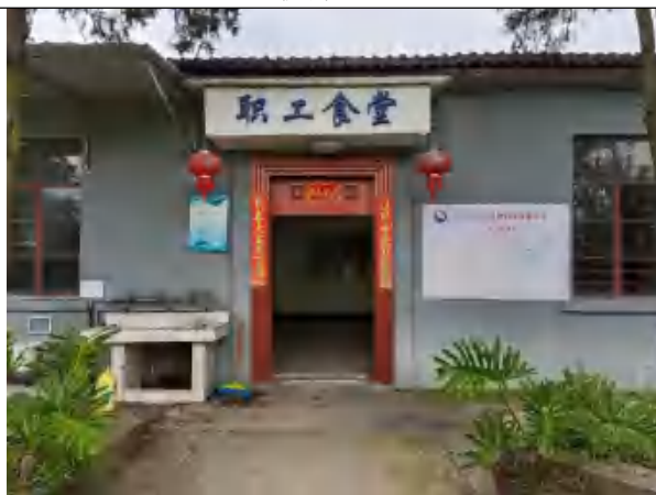
云南云叶化肥股份有限公司已建食堂
