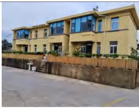
云南云叶化肥股份有限公司已建办公楼
