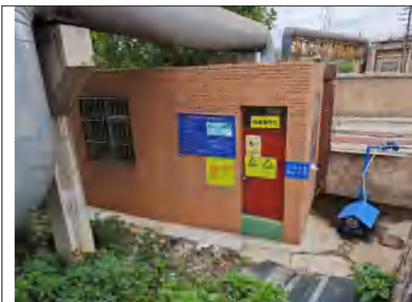
云南云之叶生物科技有限公司已建危废暂存间
