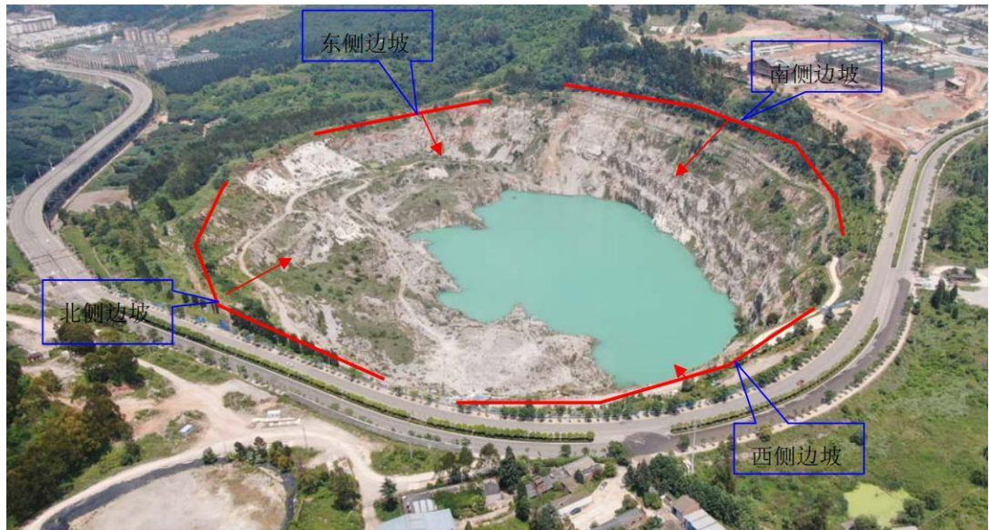
图2.3-1稳定边坡现状
