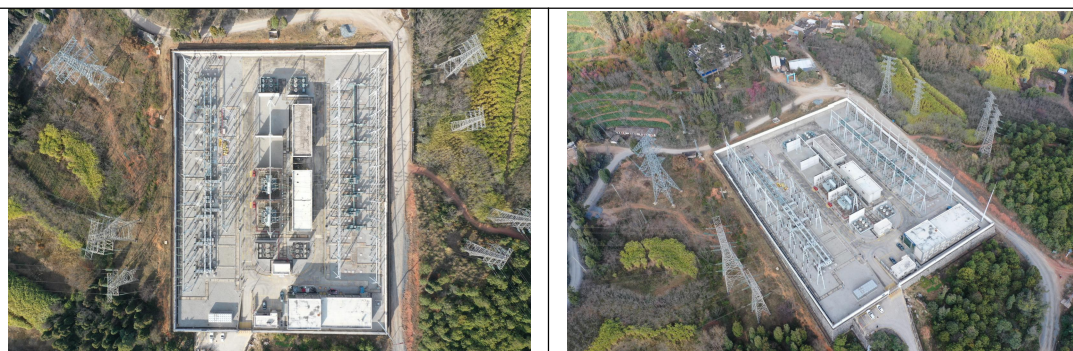
220kV 温泉变电站站外环境现状
