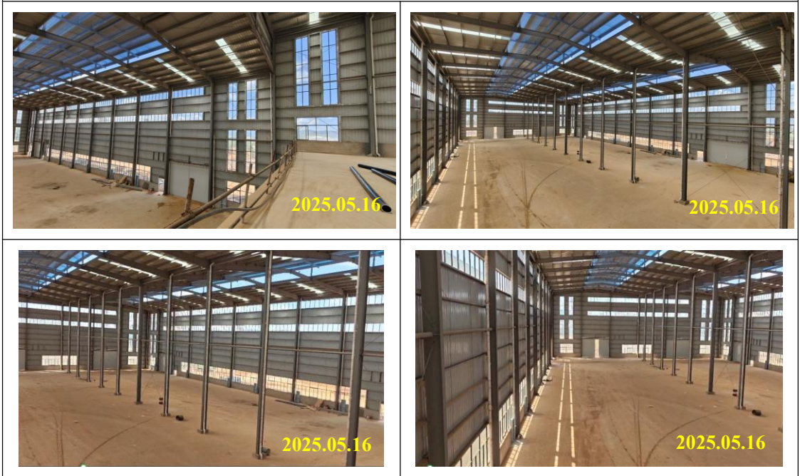
项目区场地现状
