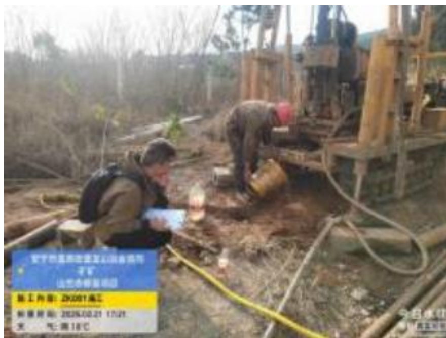
图 4-19 ZK001 钻孔注水试验
