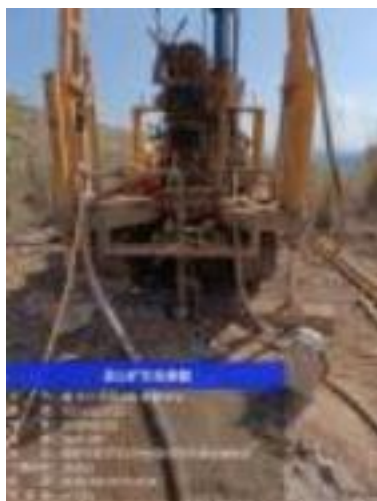
图 4-17 现场抽水试验
