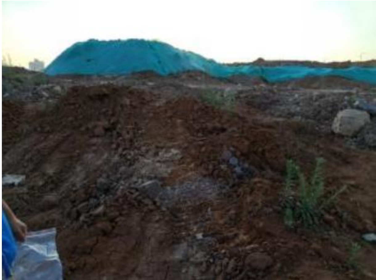
图 2-2 安宁工业园区大宗工业物资公铁联运物流园配套基础设施（一期）工程项目剥离表土
