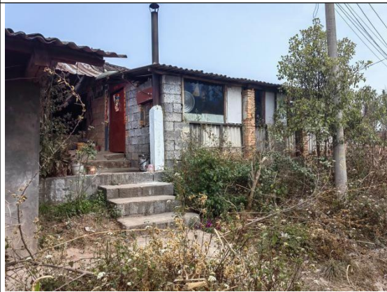
老潘木业有限公司职工临时住宿区现状
