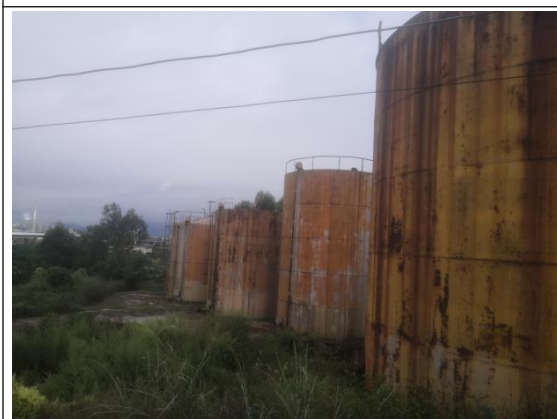
公司现有储罐现状
