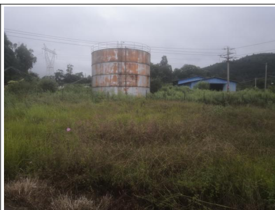
公司现有储罐现状
