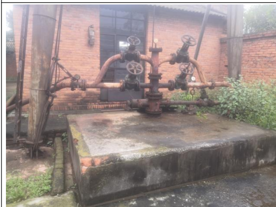
公司现有一号盐井现状
