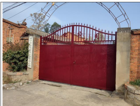
安宁市志远盐业化学有限公司现状
