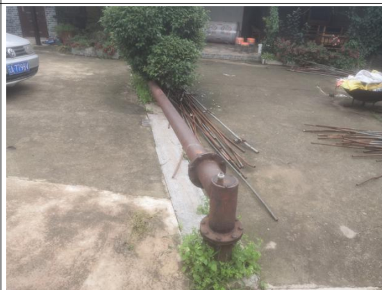
公司现有四号盐井现状
