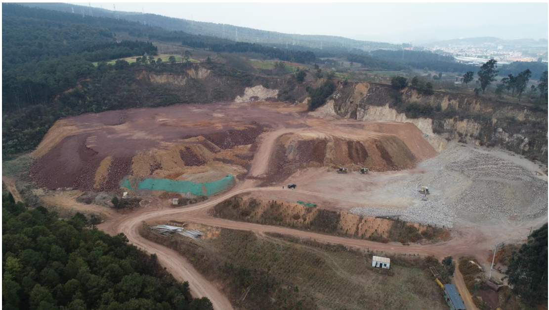
图 2-12 实施范围西侧、中部区域现状情况
