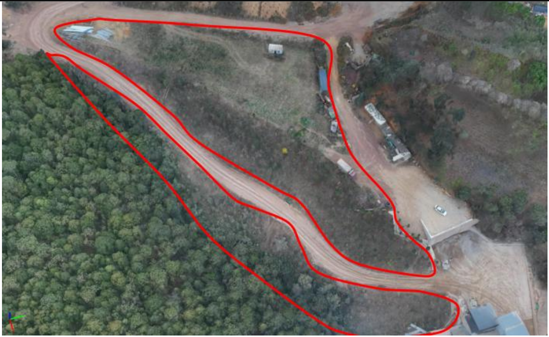
图 2-13 实施范围东侧、东南侧区域现状情况
