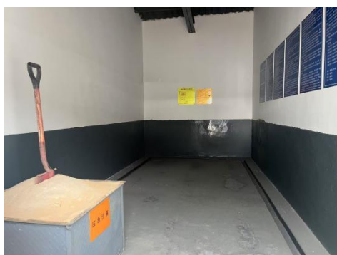
危废暂存间放渗漏措施
