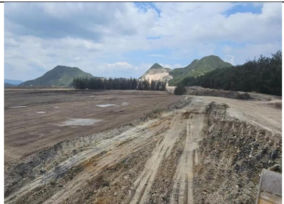
项目整体区域现状
