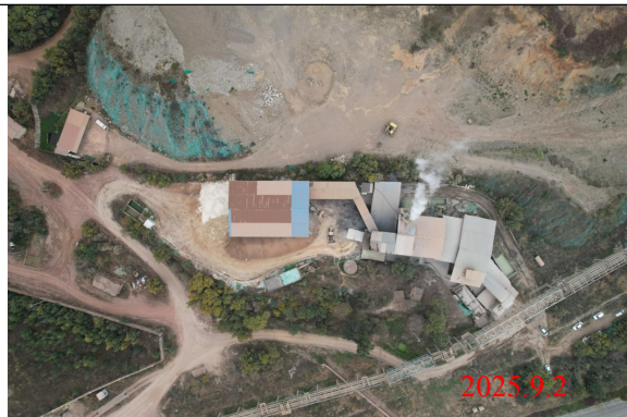
搬迁前现有项目厂址现状（原有厂房）
