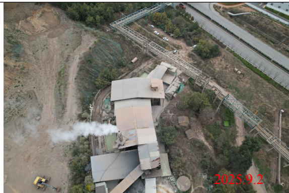
搬迁前现有项目厂址现状（原有厂房）
