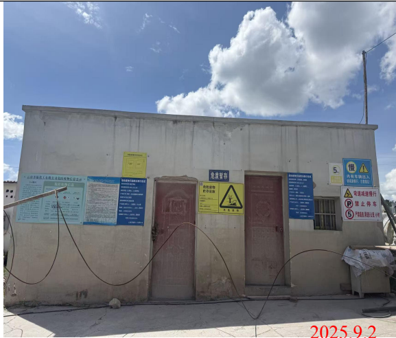
依托危废暂存间
