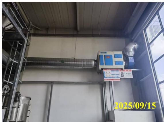
图 8 车间内废气处理设施
