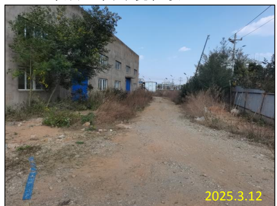
项目厂区内部环境现状（一）
