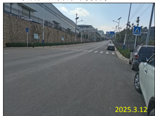
项目南侧园区道路
