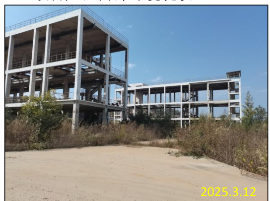
项目厂区内部环境现状（三）
