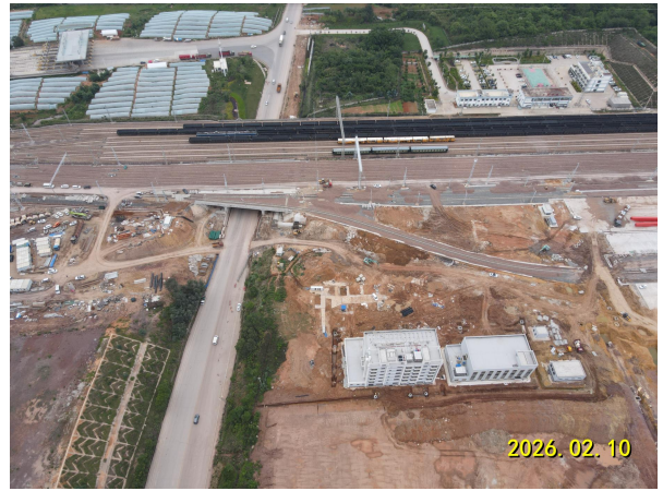
在建综合楼及宿舍楼
