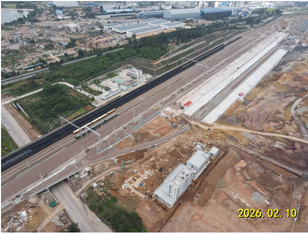
项目区南部现状
