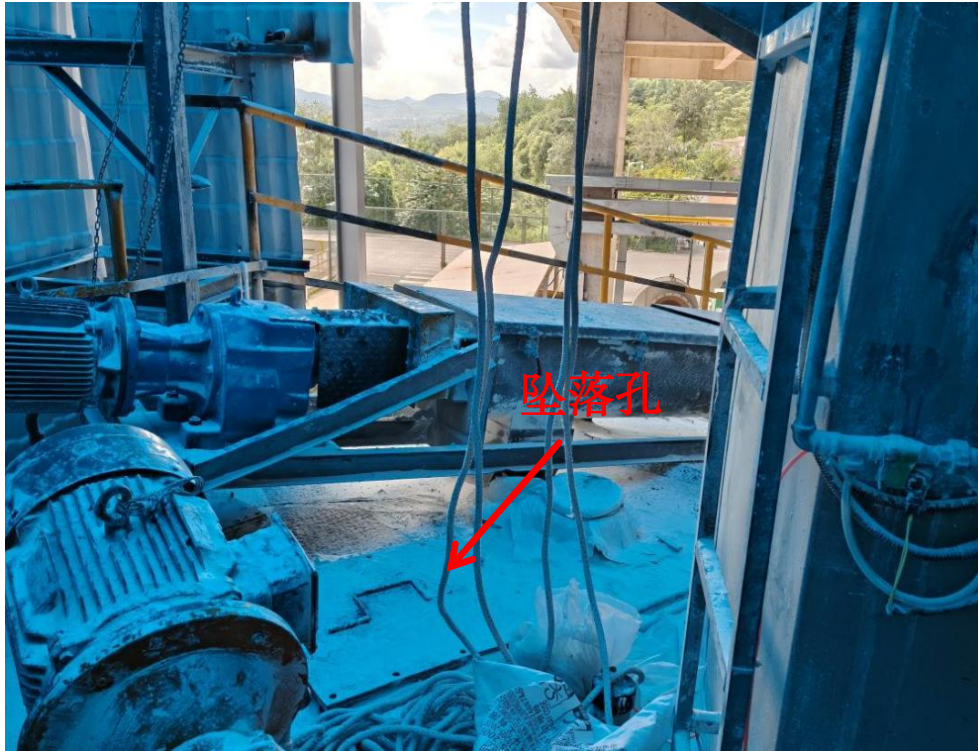
图 4: 萃余酸装置中间仓顶部平台
