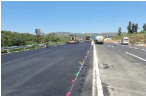
图 1-3 县草公路沥青路面工程
