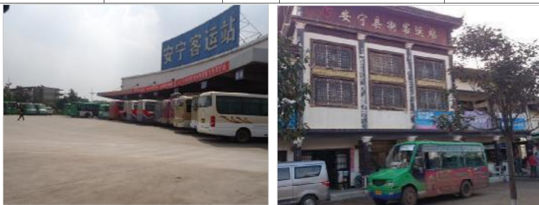
图 1-11 安宁公路客运站现状
