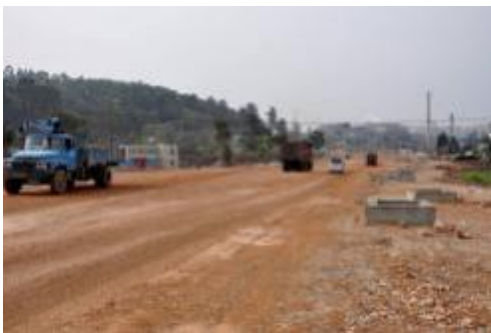
图 1-1 安海公路施工现场
