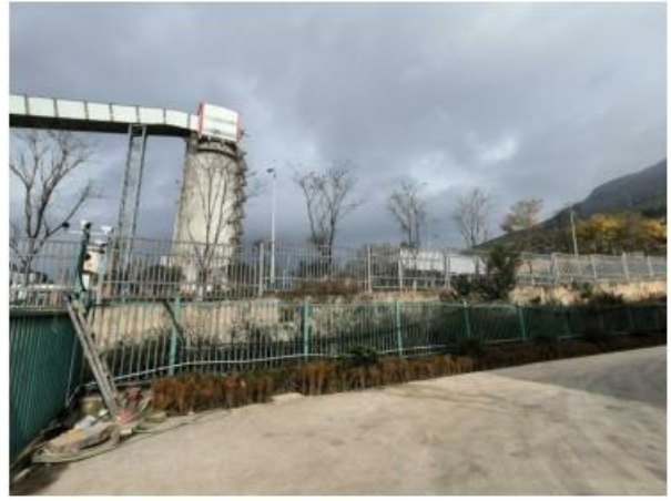
租用厂房厂区西南侧
