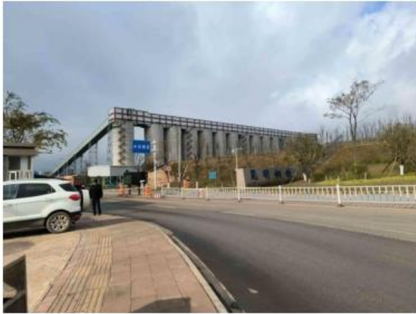
租用厂房厂区西北侧
