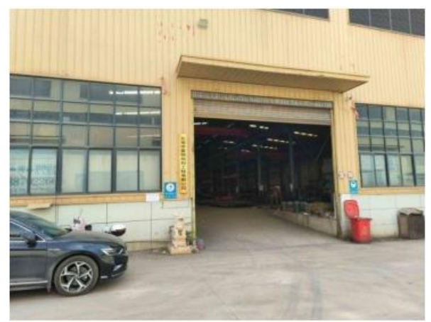
拟用厂房东南侧钢结构生产企业
