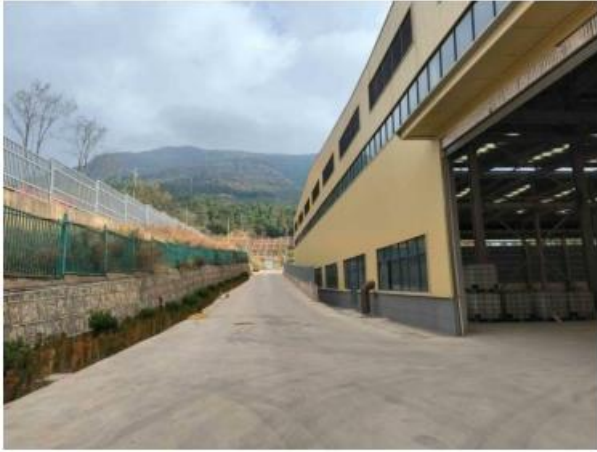
拟用厂房西北侧
