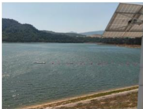
安宁市农林水利投资有限公司备用水源工程取水设施
