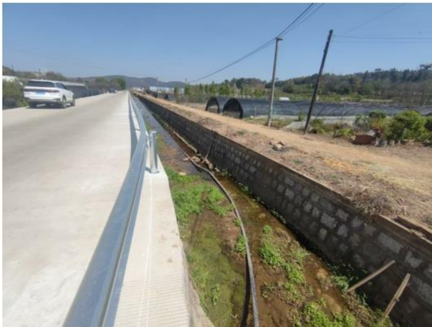
上图为县街河汇入鸣矣河附近，由于缺水，周边农户采用管道沿县街河河道向鸣矣河取水返回至县街河河道进行农灌
