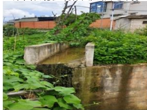
排污口位置（依托农灌沟汇入县街河处）
