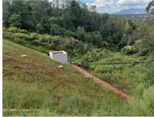
污水管线接入现有农灌沟周边环境
