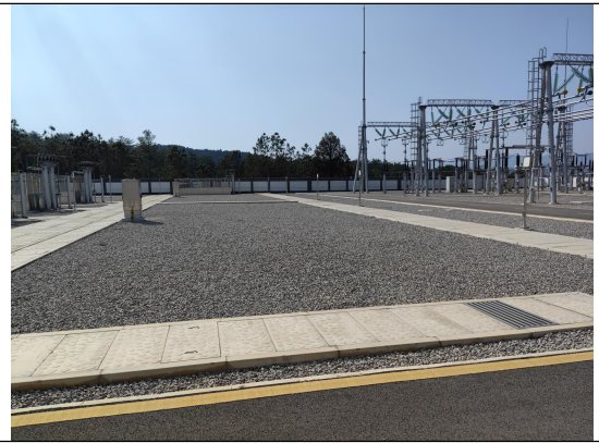
站内硬化道路
