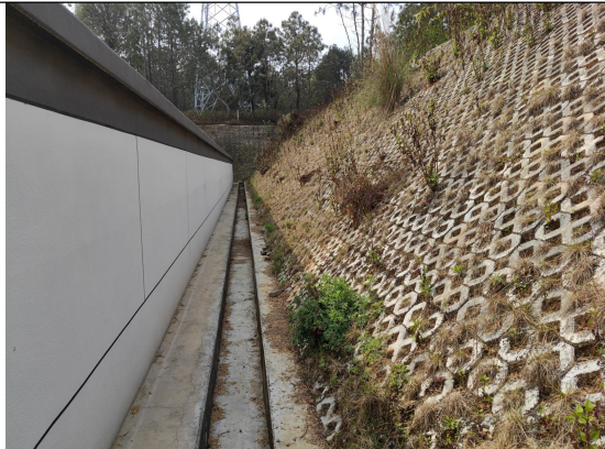
站外排水沟、护坡及变电站实体围墙
