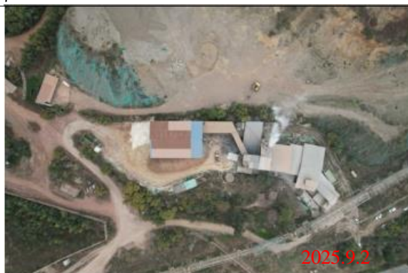
搬迁前现有项目厂址现状（原有厂房）
