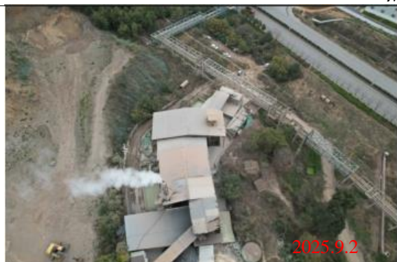
搬迁前现有项目厂址现状（原有厂房）
