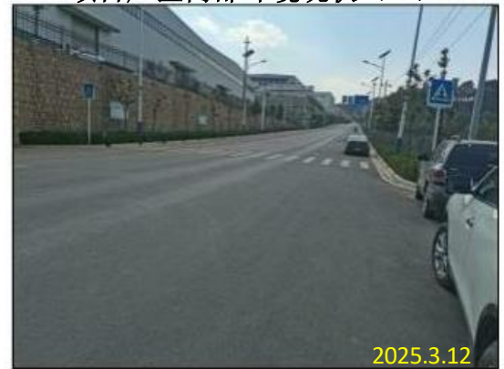
项目南侧园区道路
