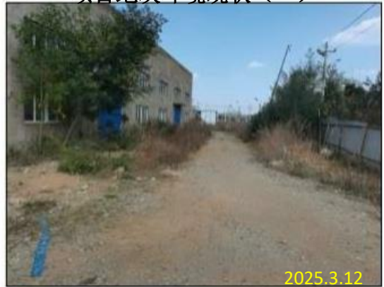
项目厂区内部环境现状（一）
