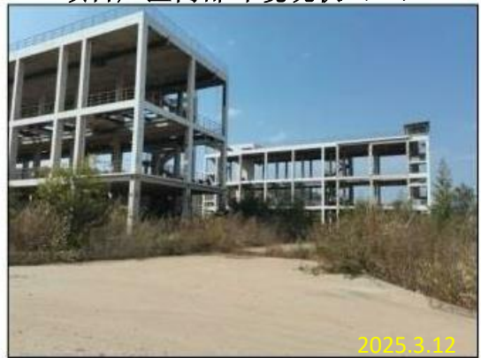
项目厂区内部环境现状（三）
