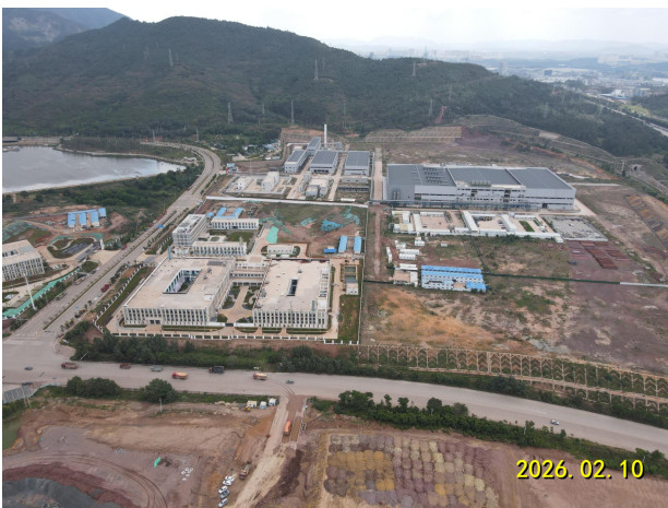
项目区东北侧
