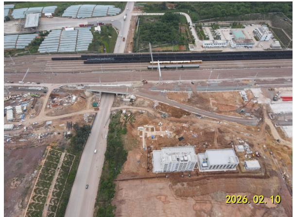
在建综合楼及宿舍楼
