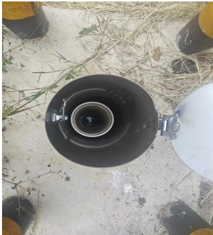
图 2-9 地下水监测井井管替换
