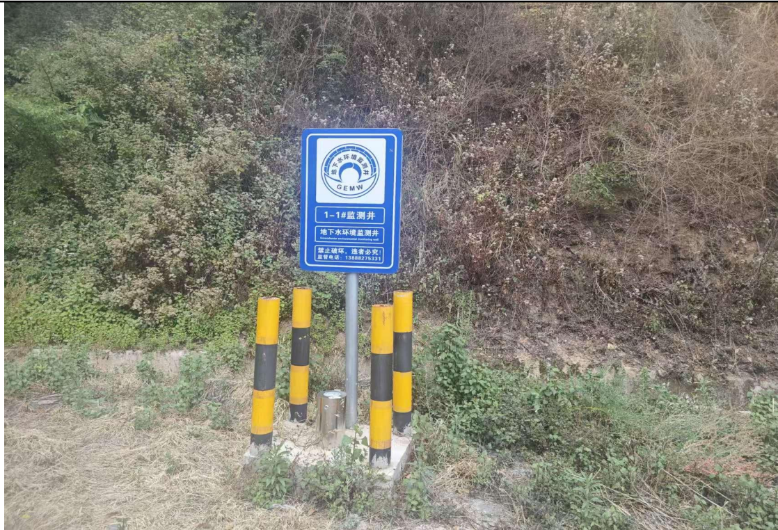
图 2-8 检测井井台、井盖、图形标等规范建设
