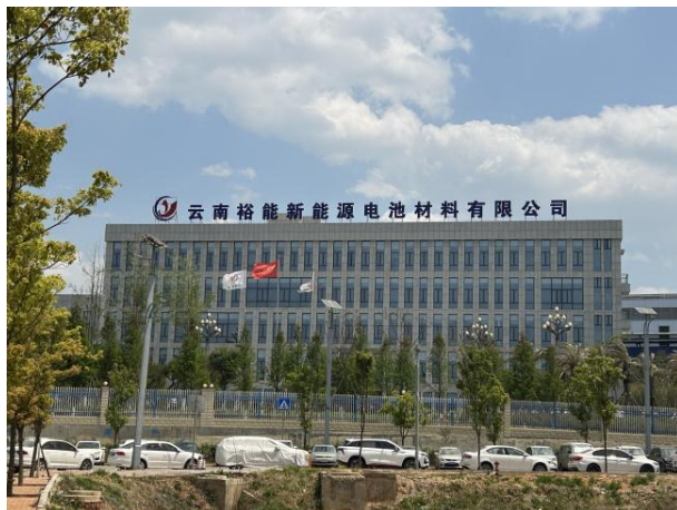
厂区东南侧 云南裕能新能源电池材料有限公司
