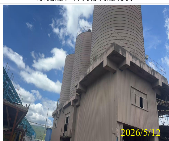
粉煤灰仓现状
