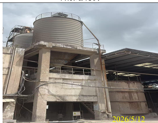
水泥罐和石灰粉灰罐现状
