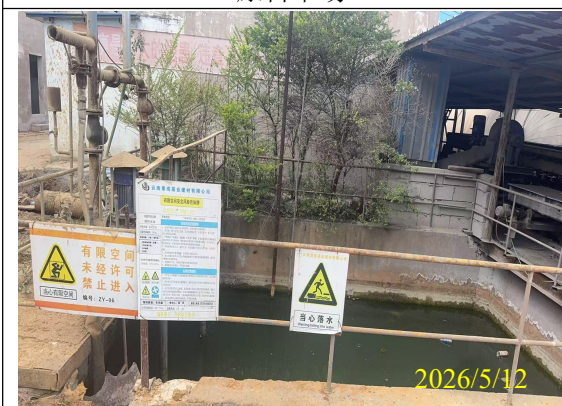
生产废水沉淀池
