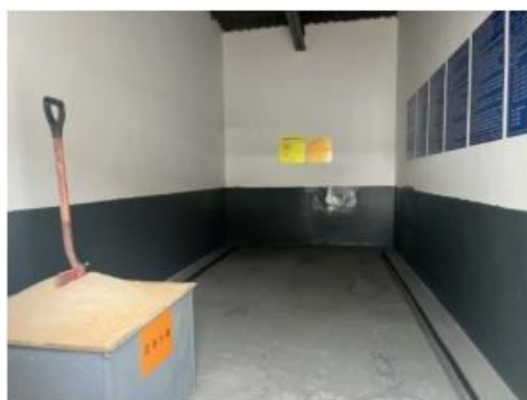
危废暂存间防渗漏措施
