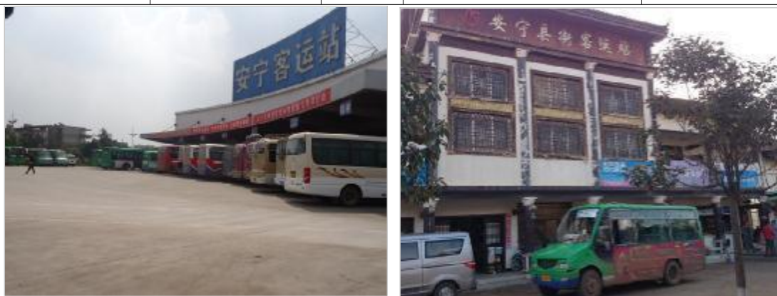
图 1-11 安宁公路客运站现状
