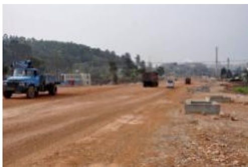
图 1-1 安海公路施工现场
