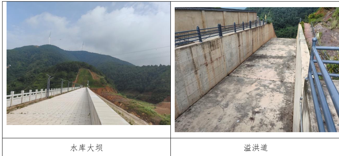
图 2.5-1 箐门口水库现场照片
